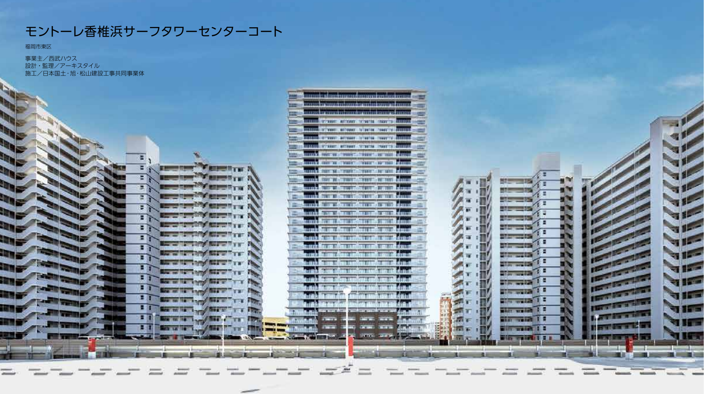
北側全景 中央がモントーレ香椎浜サーフタワーセンターコート
